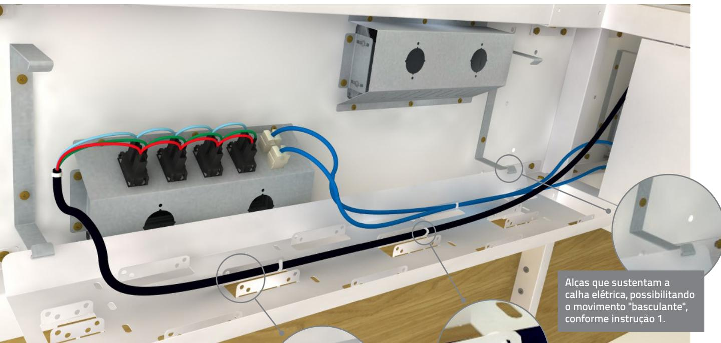
**i** Levantando as abas auxiliares, formam-se 3 canais para passagem da fiação (elétrica, dados e voz), facilitando a separação dos fios.
